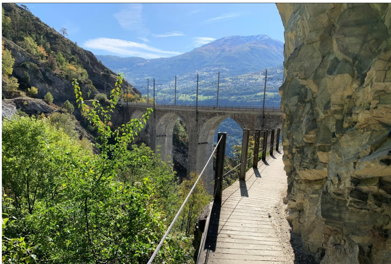
Viadotto Luogelkin. La parte destra è stata aggiunta per il raddoppio della linea
