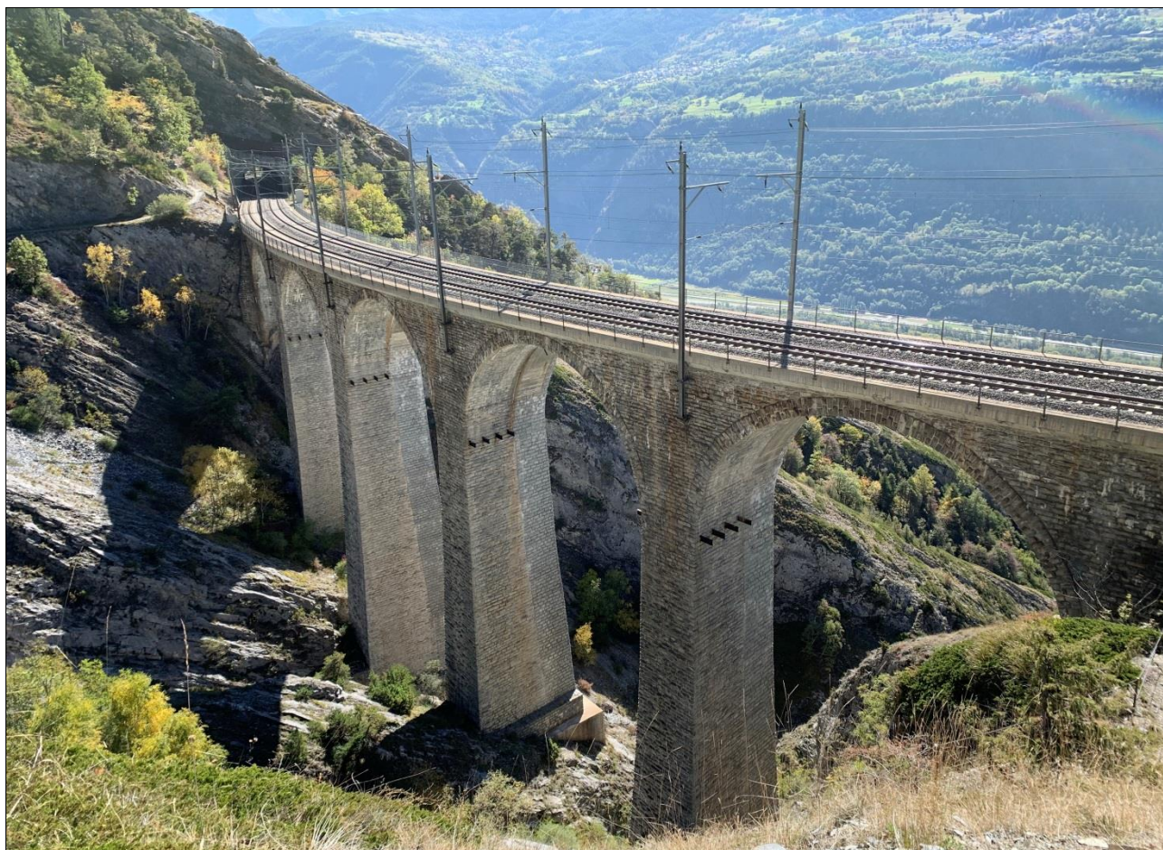
Viadotto Luogelkin. La parte destra è stata aggiunta per il raddoppio della linea
