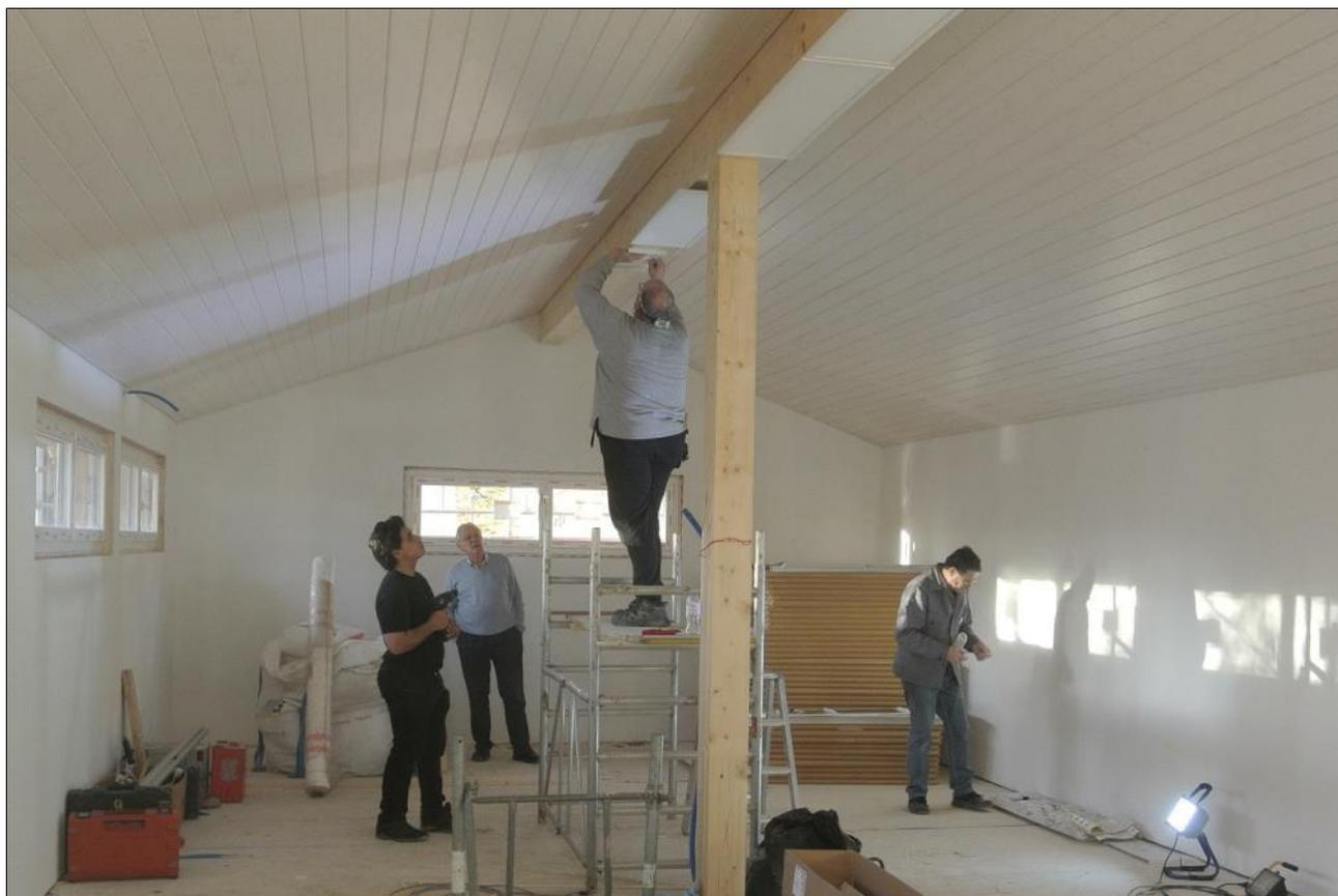
25.11.2017 – posa delle 9 lampade LED con colore/intensità regolabili (totale 320 W, 30'000 lumen)
