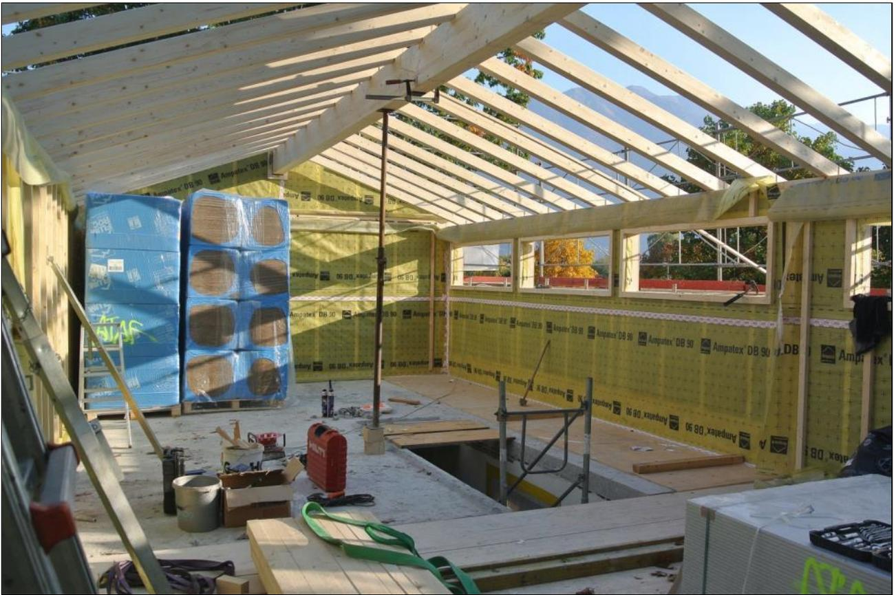
18.10.2017 – posa dei travicelli del tetto. È visibile l'isolazione e il passaggio per la scala interna.
